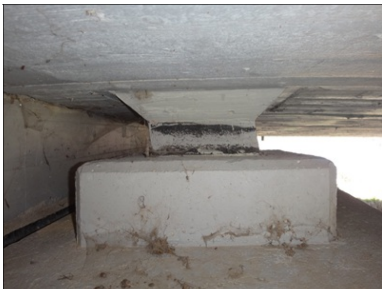
Ložiska na podpěrách
