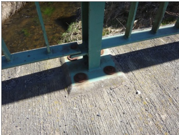
Koroze kotvení zábradlí
