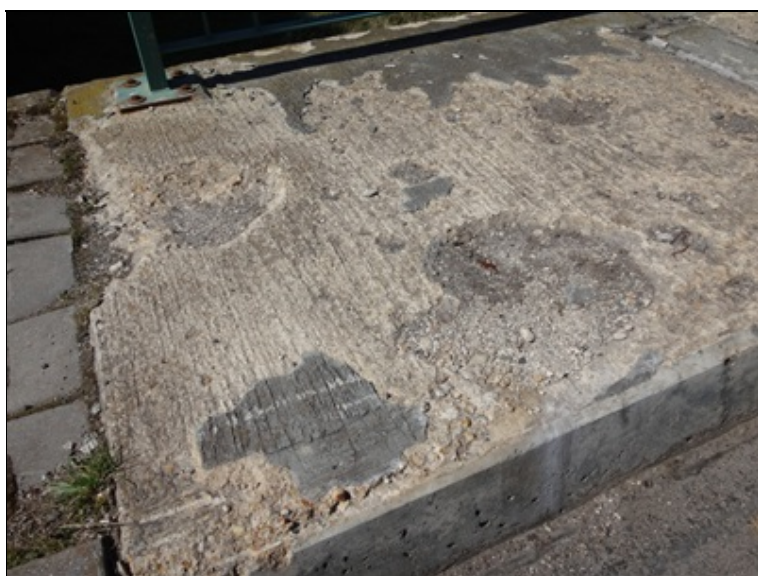
Poruchy povrchu říms
